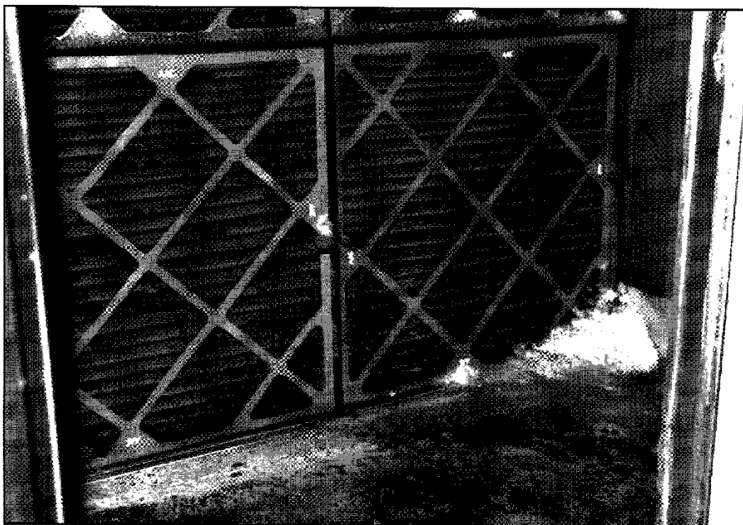
Figure 3.4: Filtres endommagés par les conditions environnementales extérieures
