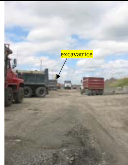
Figure 9 : Second aperçu du chantier
