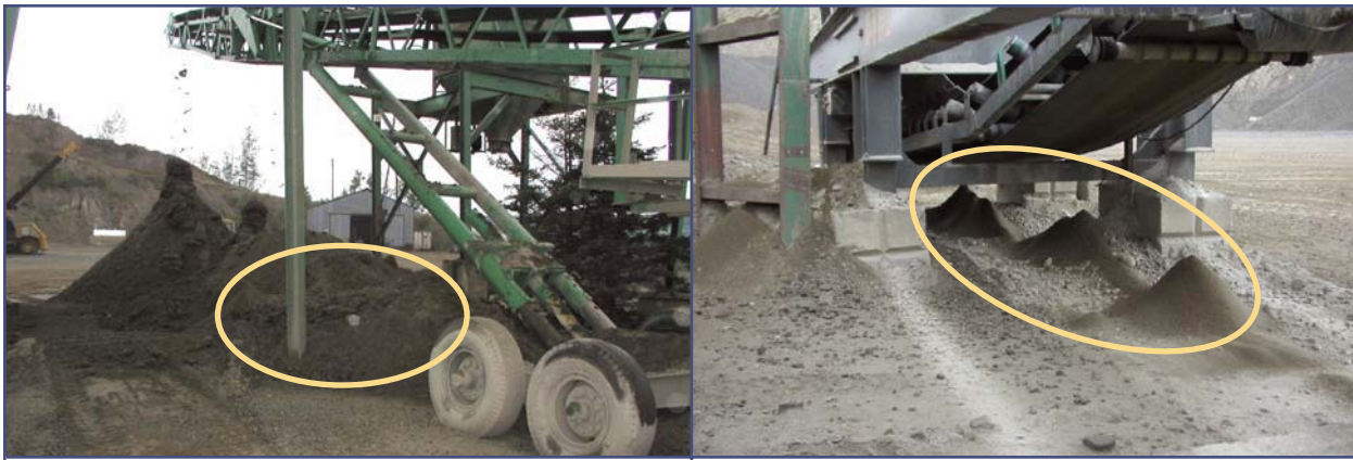
FIGURE 3-21 ACCUMULATION NON DÉSIRÉE DE MATÉRIAUX TRÈS HUMIDES
