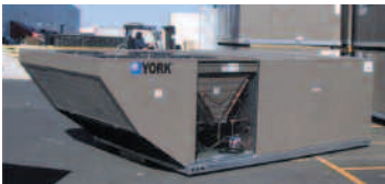
3.2 Système de ventilation/conditionnement de l'air de toiture
