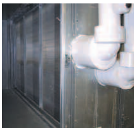
3.7 Serpentin de chauffage à eau chaude
