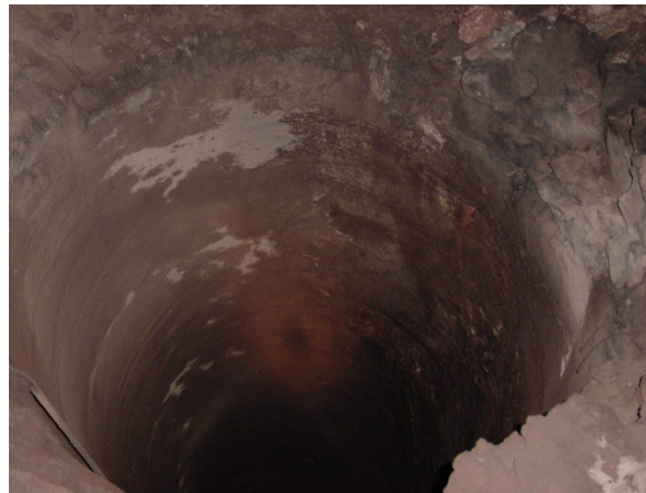
Illustration 8 : vue d'une cheminée de ventilation; creusage par RBM.
