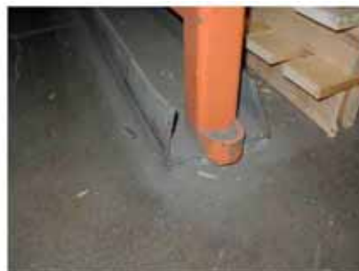
Figure 25 : Cornière de protection du palettier tordue
