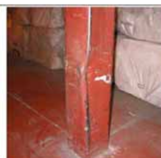
Poteaux et éléments de structure accrochés
