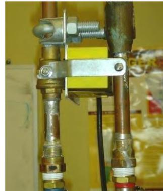
**Figure 24: Installation du capteur de proximité (jaune)**
