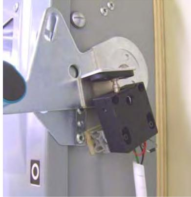
**Figure 25: Cadenas électronique installé sur le sectionneur à fusibles**
