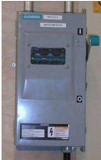
Figure 10: Sectionneur à fusibles principal
