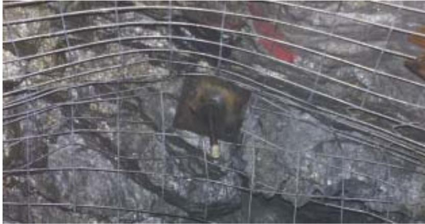
Figure 23 : Boulons d'ancrage instrumentés SAFEBOLT de 5/8"
