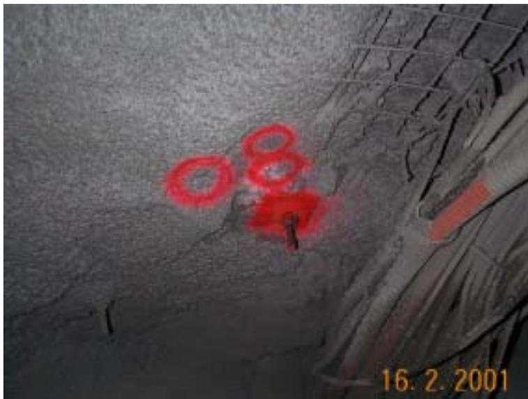
Figure 42 : Boulon instrumenté SAFEBOLT n° 8
