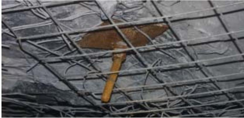
Figure 26 : Dommage causé à la tête d'un boulon de la mine Doyon par suite de dynamitage
