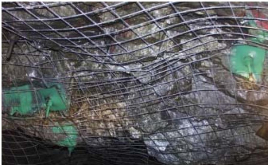
Figure 24 : Marquage à l'aérosol des boulons instrumentés
