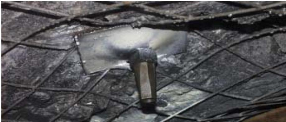
Figure 27 : Protection du dispositif SAFEBOLT au moyen de l'écrou d'une coquille d'expansion
