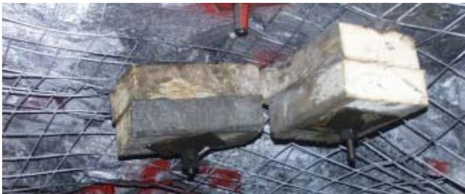
Figure 28 : Coussinage des boulons instrumentés au moyen de blocs en bois pour les protéger des effets de dynamitages ultérieurs
